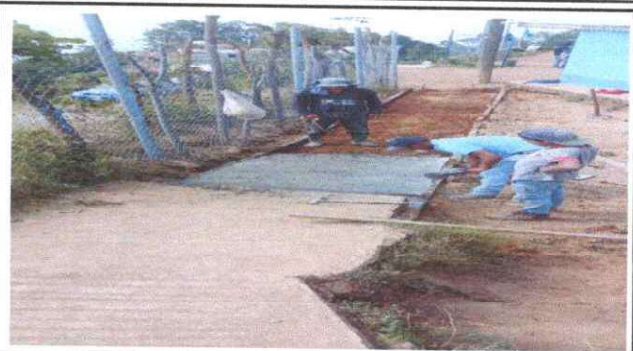
Foto 2: Se remodelará una rampa en la entrada de los baños
