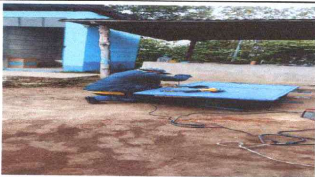
Foto 3: Se colocará puertas de metal de los baños
