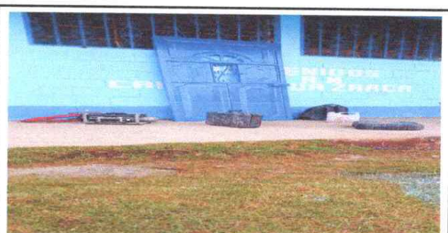
Foto 6: Se hará la colocación de puertas de metal aulas, dirección
